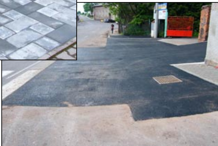
Opravená cesta u obchodu
